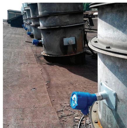
Рис. 2. Установка пылемера ProSens: а – схема установки; б – фотография с объекта
